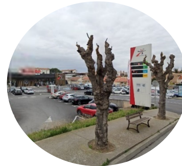
Des Moyennes surfaces alimentaires qui manquent parfois d'innovations et d'attention portée aux connexions urbaines et aménagements
