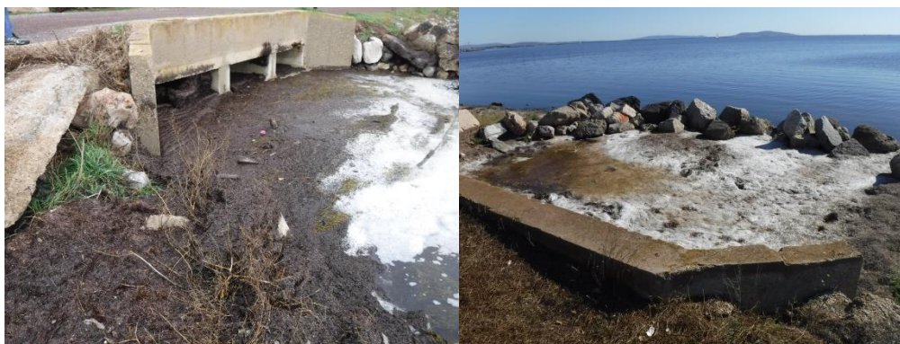
Figure 2 : Exutoire pendant et après un épisode pluvieux
