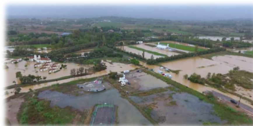
Plaine du Sesquier et complexe sportif après le débordement du Pallas lors de l'évènement du 13 et 14 octobre 2016
